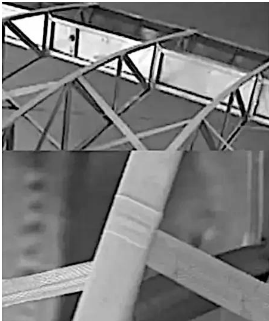
Figure 19. Le contreventement inter-nervures maintient les nervures en place pendant le processus de recouvrement.
