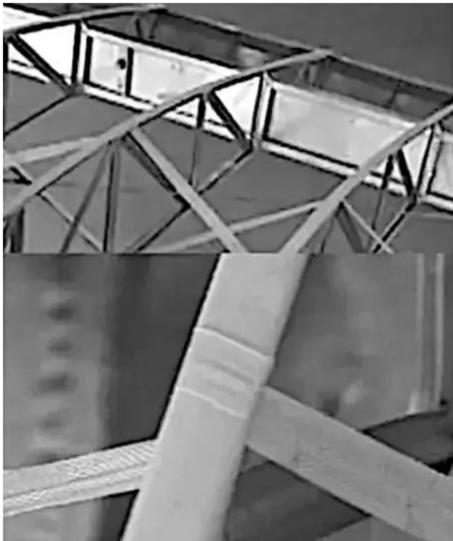
Figure 19. Le contreventement inter-nervures maintient les nervures en place pendant le processus de recouvrement.
