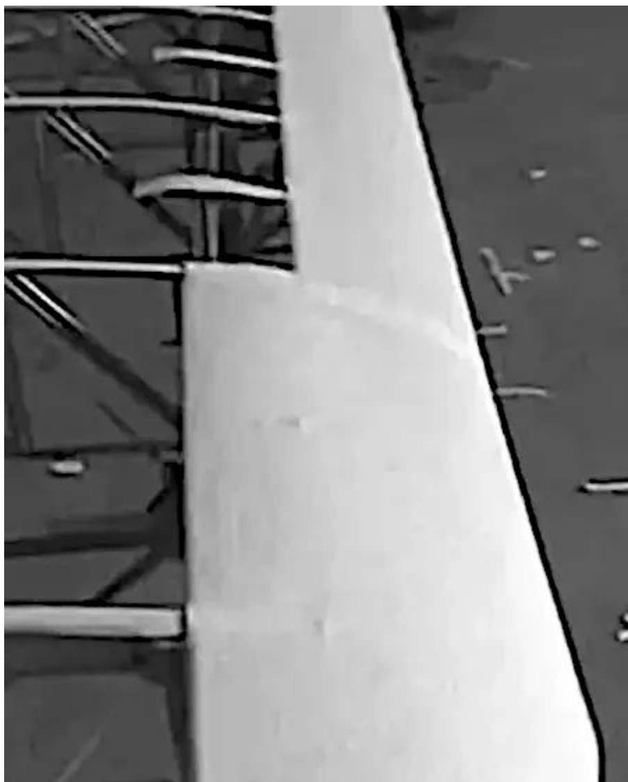
Figure 17. L'utilisation de feutre ou de rembourrage spécifié sur les bords d'attaque des ailes avant l'installation du tissu permet d'obtenir une surface lisse et régulière.
