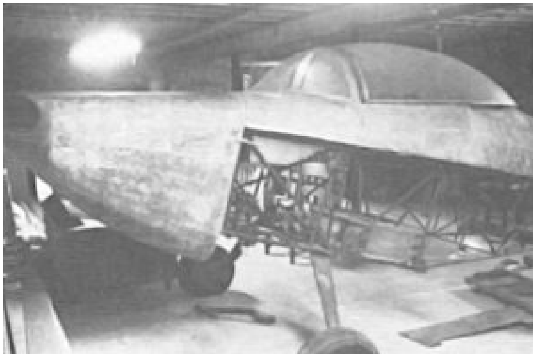
Vue montrant la continuité entre le capot moteur et la verrière
