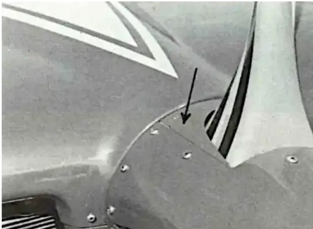
Photo 2 : Remarquez comment l'espace est scellé avec un insert métallique maintenu en place par des vis avec écrous à sertir.
