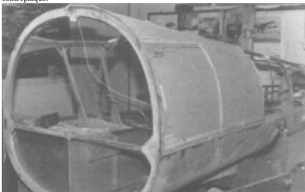
Photo 3 : Pour obtenir l'aspect extérieur le plus lisse, essayez toujours de couvrir au moins trois cadres ou cloisons avec une seule section de contreplaqué comme montré ici.
