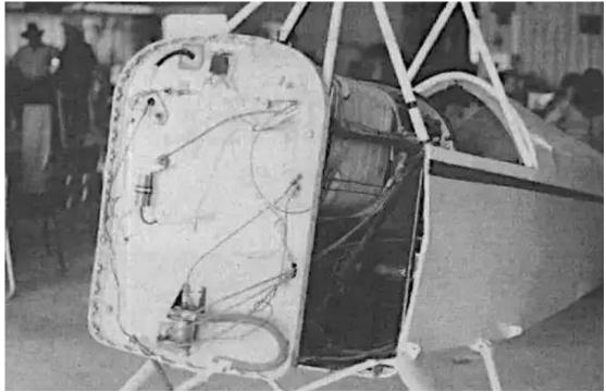
L'installation du moteur commence réellement par la préparation du pare-feu. En général, tous les trous et ouvertures du pare-feu sont réalisés et les accessoires y sont fixés avant que le support moteur et le moteur ne soient boulonnés en place.
