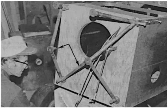
Ce pare-feu en contreplaqué épais de type VP-1 est en cours de modification pour pouvoir recevoir un support moteur de type aéronautique. Une plaque de métal galvanisé, posée sur une couche d'amiante, doit encore être installée. La grande ouverture permet à la magnéto unique de dépasser à travers le pare-feu. L'ouverture de la magnéto sera recouverte d'un bol en acier inoxydable fixé depuis l'intérieur du cockpit.
