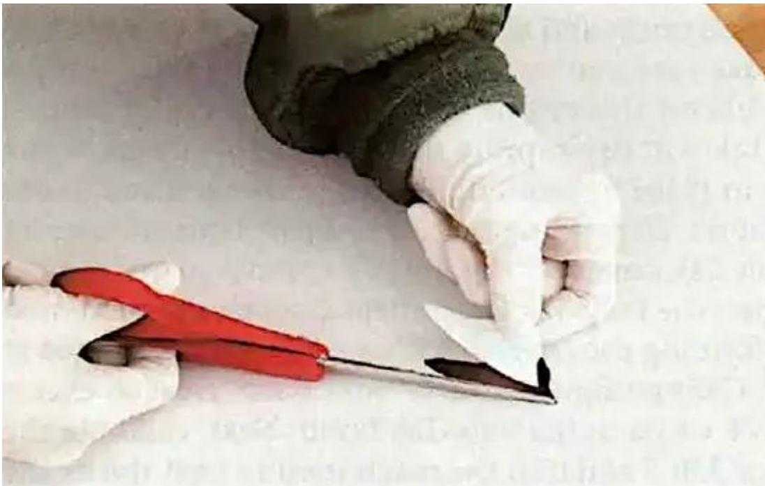
Découpe de l'entoilage endommagé
