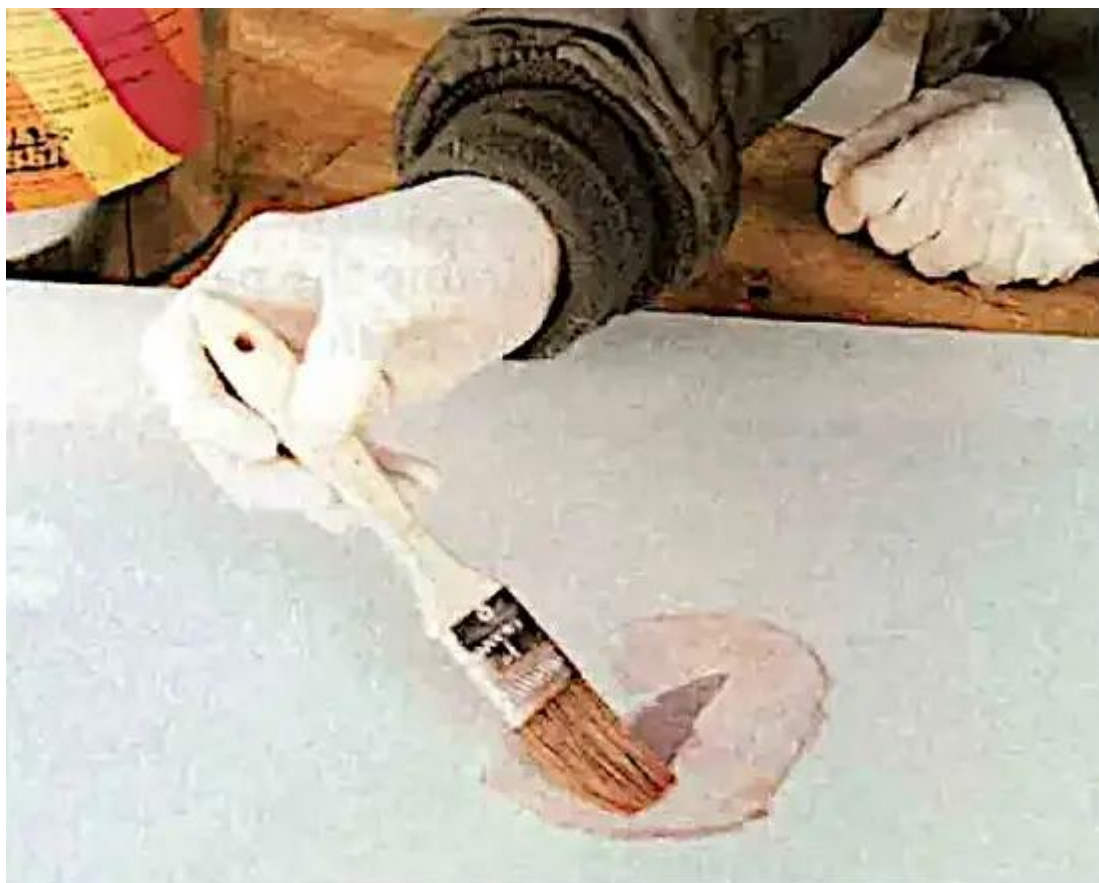
Application au pinceau de la première couche de Poly-Brush
