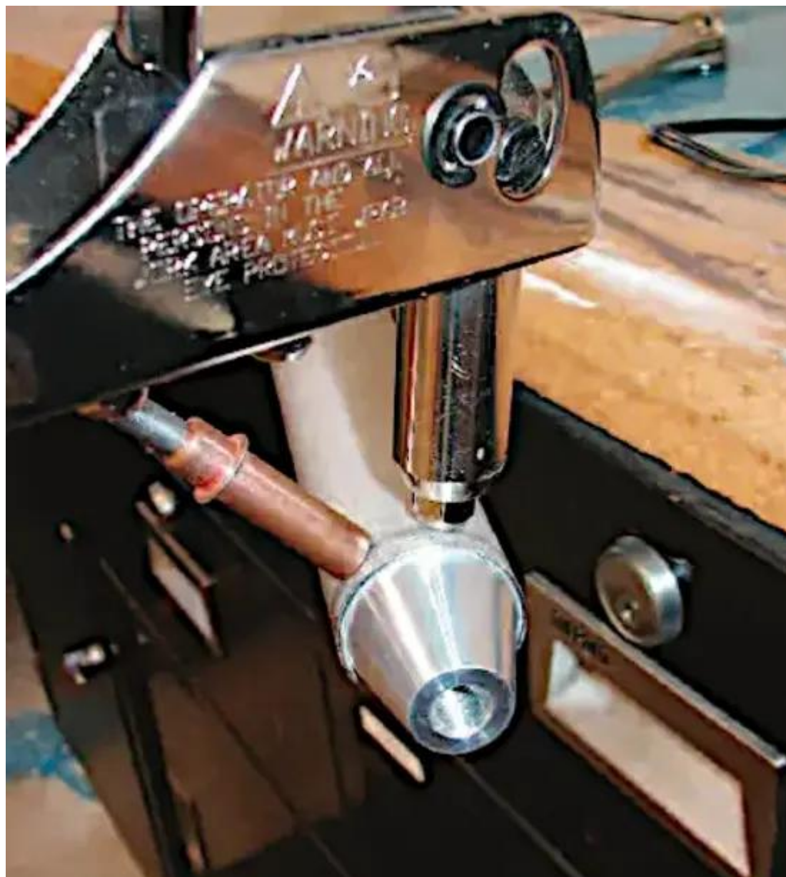
Après nettoyage et application d'un apprêt, les rivets aveugles sont posés.
