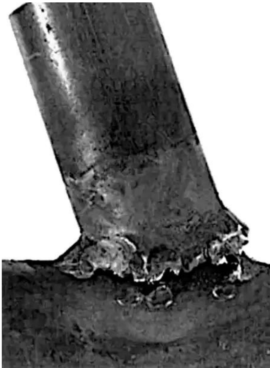
Cette photo en gros plan montre une rupture de la soudure au milieu du cordon.
