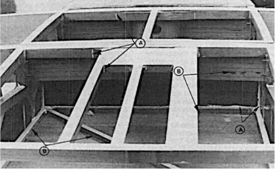
Les zones révélatrices de débordement de colle blanche, «A», indiquent que l'adhésif époxy Hughes FPL-16A a été utilisé. Les lignes de colle plus foncées, «B», prouvent qu'une résorcine a été utilisé à ces endroits. Il n'existe aucune règle imposant l'usage d'un seul type d'adhésif dans un projet.
